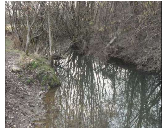
Photo n°10 : Vue du canal de fuite
