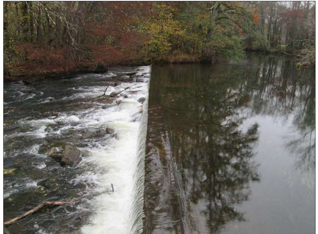
Photo n°5 : Vue de la crête du barrage et de l'échancrure centrale
