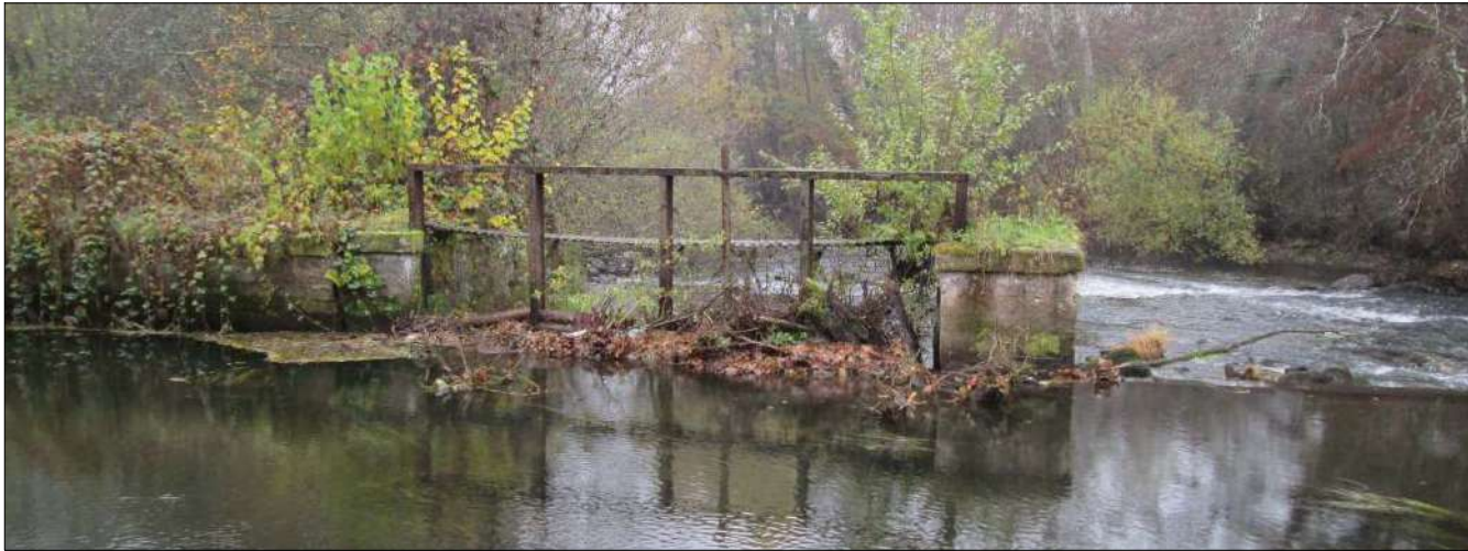
Photo n°3 : Vue amont du vannage de décharge
