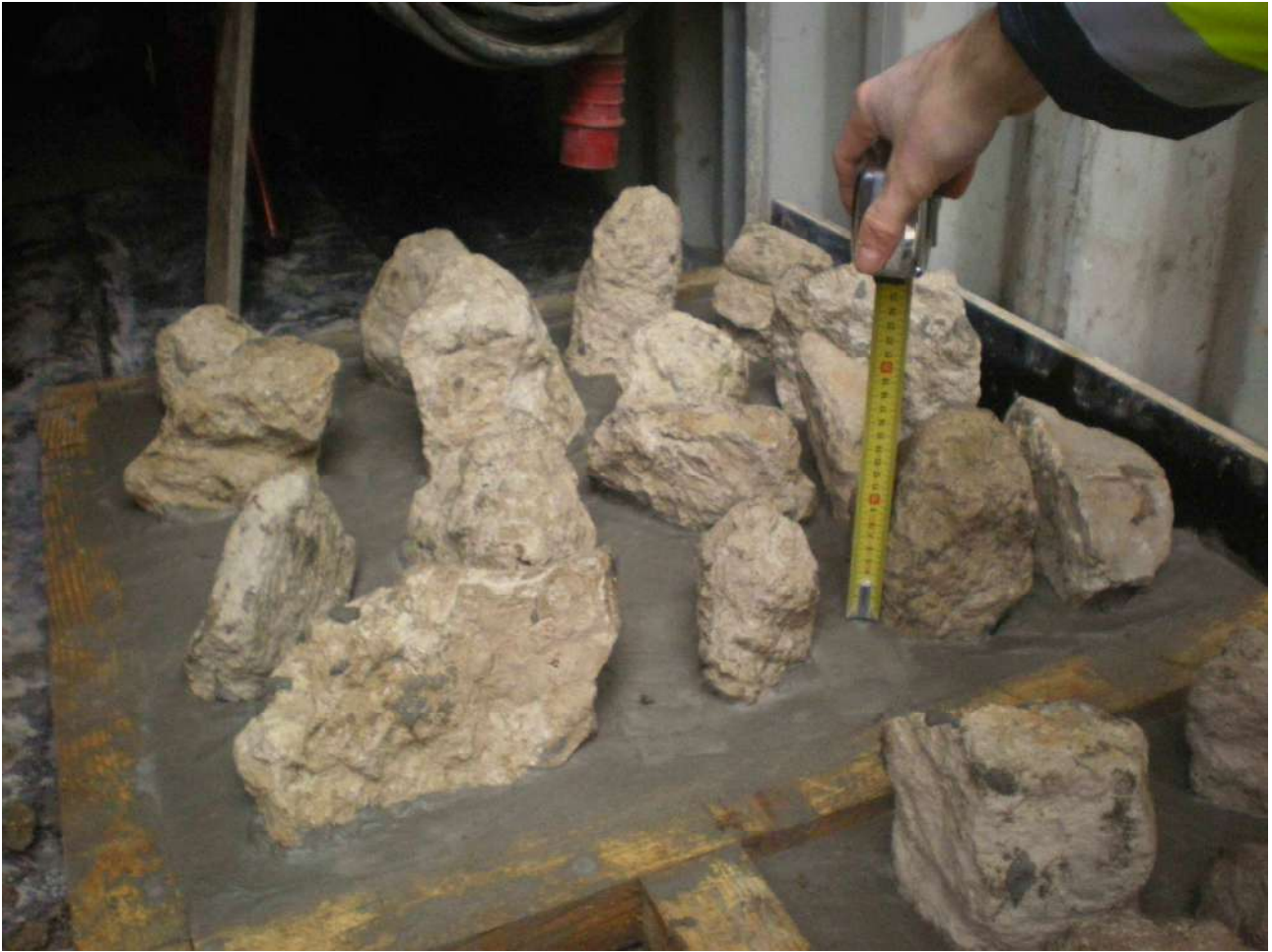
Figure 30 : Disposition de la rugosité de fond (source : OFB Bourgogne Franche-Comté)
