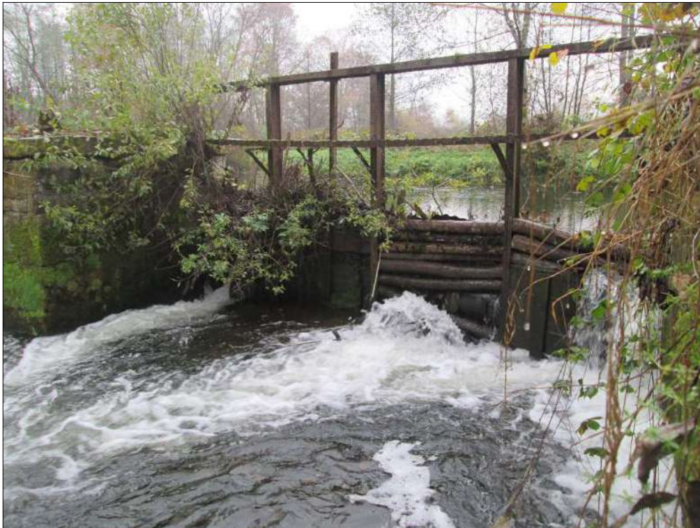
Photo n°4 : Vue aval du vannage de décharge
