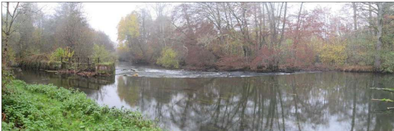
Photo n°1 : Vue amont du barrage
